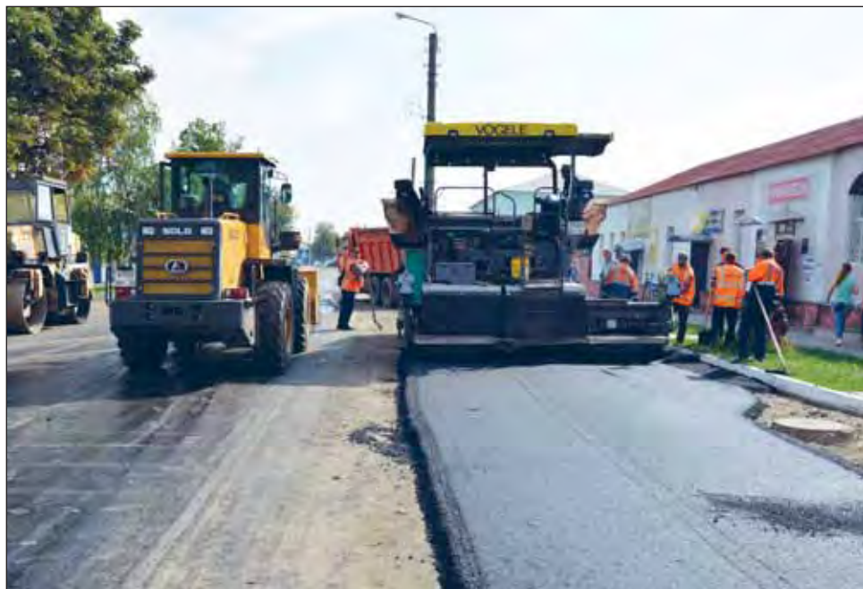
■ Одна из главных городских программ – ремонт дорожного покрытия
